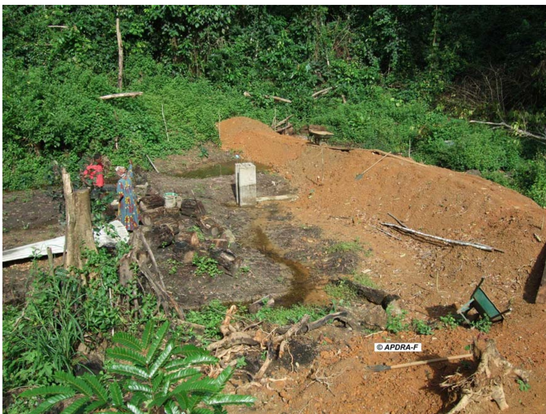
Photo 5 : Etang barrage en construction à Essambet
