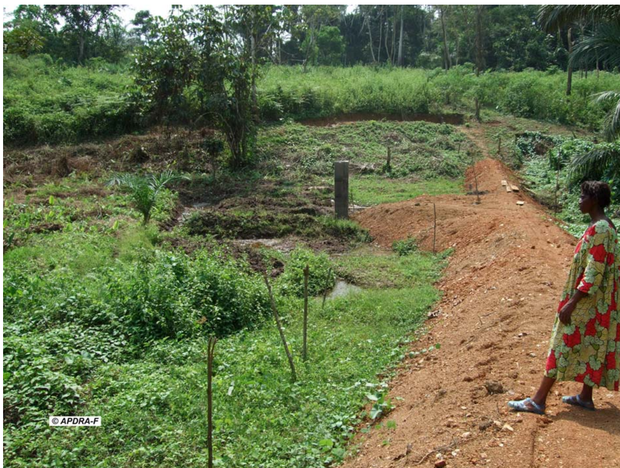
Photo 6 : Etang barrage en construction à Messeng
