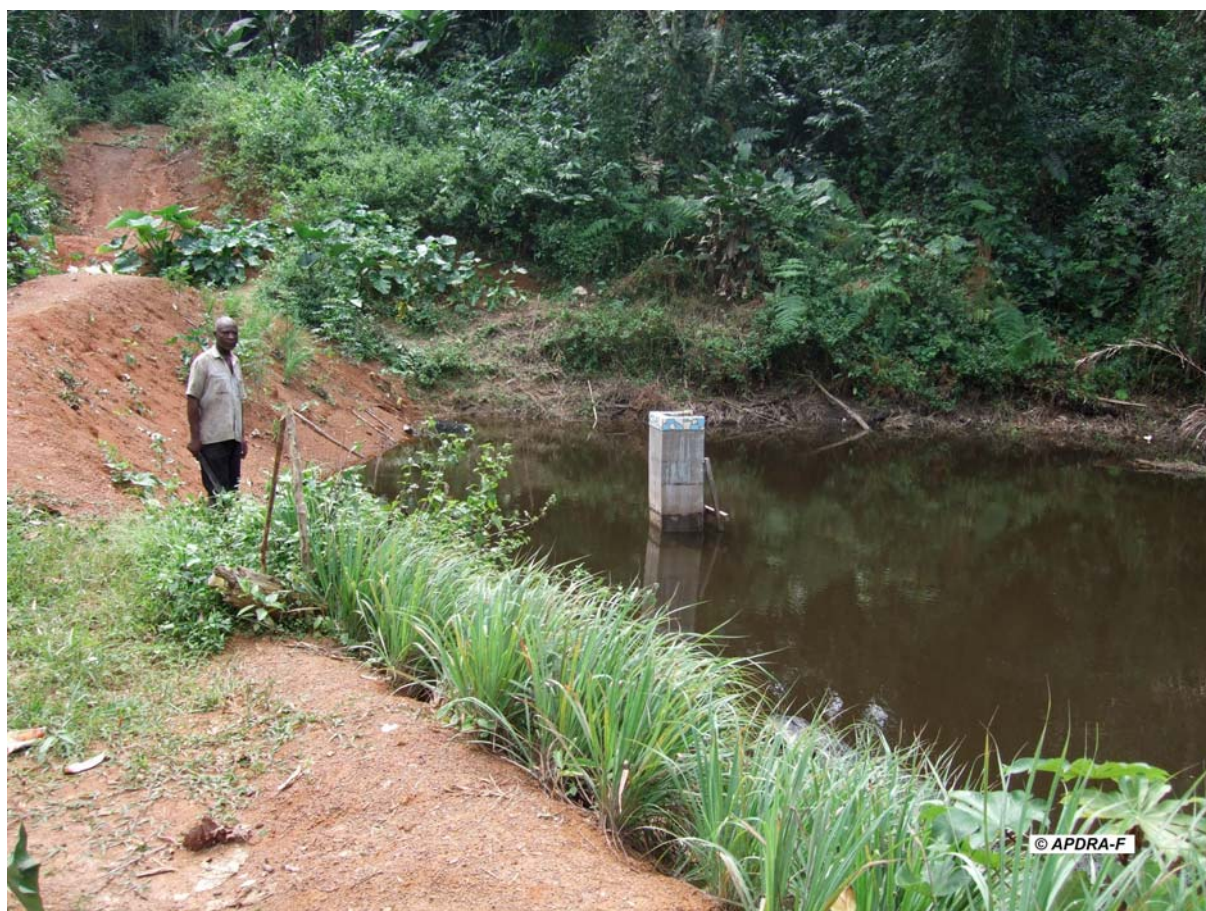
Photo 10 : Etang barrage en production à Messeng
