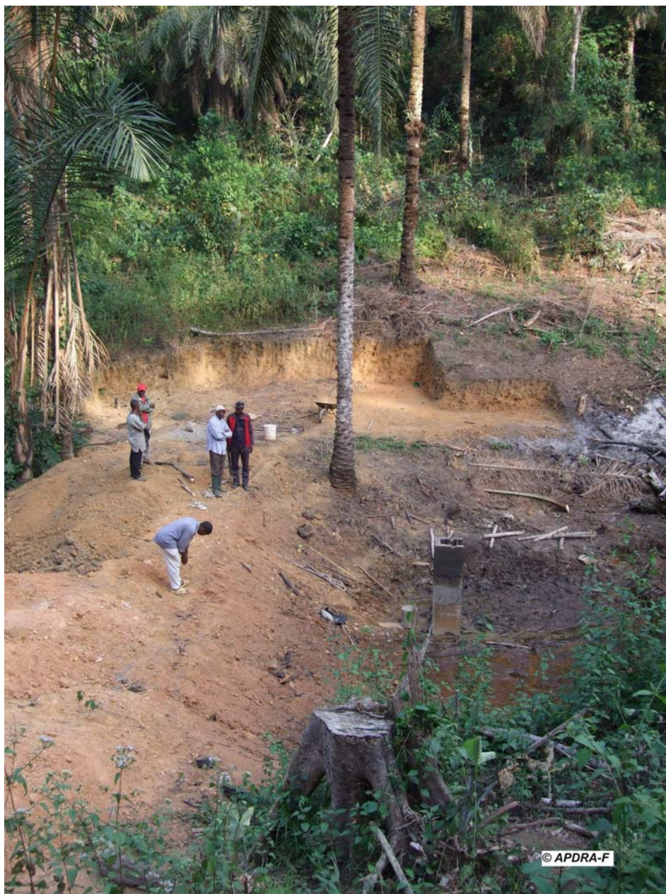
Photo 3 : Etang barrage en construction à Mom II
