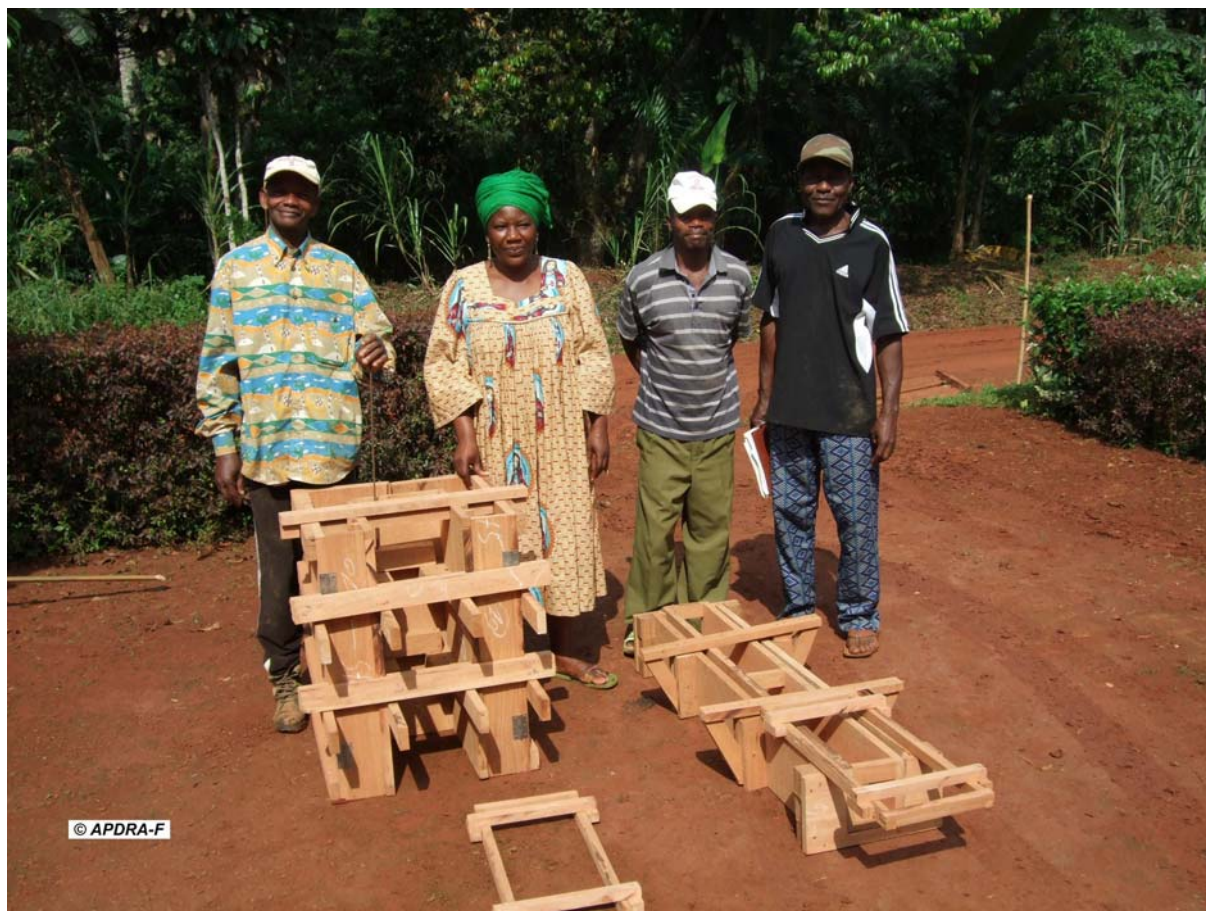
Photo 7 : Coffrages du système de vidanges terminés à Essambet
