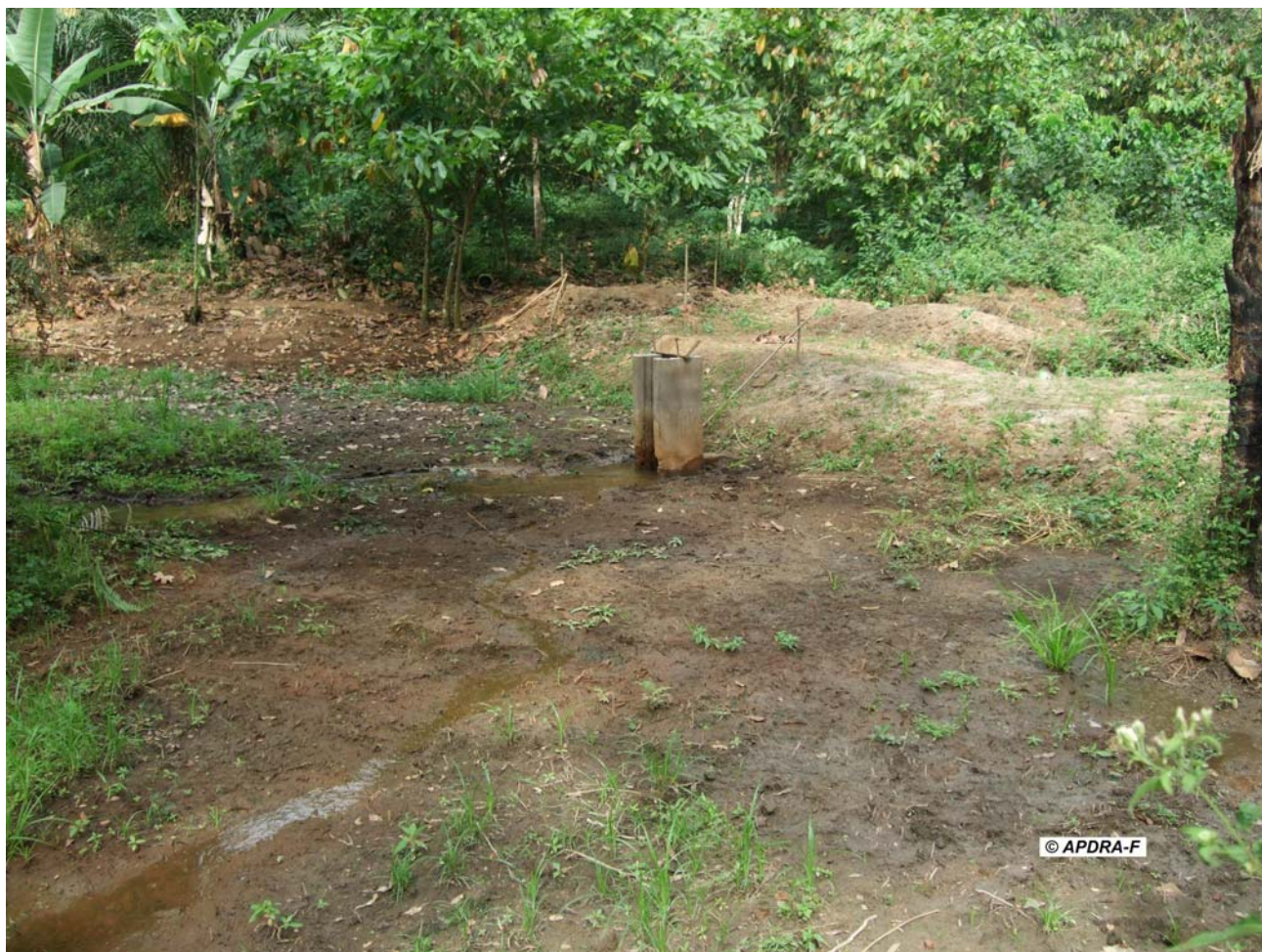
Photo 4 : Etang barrage en construction à N'kolzoa
