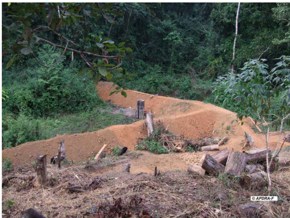
Photo 2 : Etang barrage en construction à Mom II
